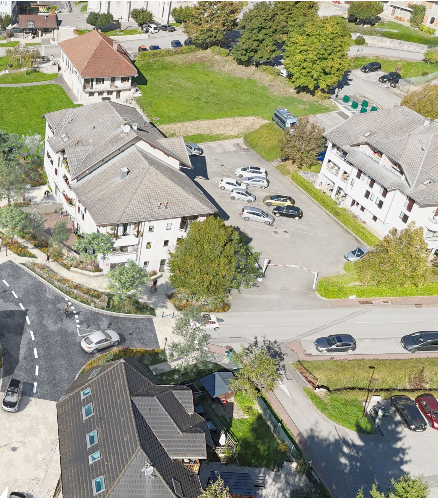
RE VILLAGE AVEC ELARGISSEMENT DES TROTTOIRS ET AMENAGEMENT DE
