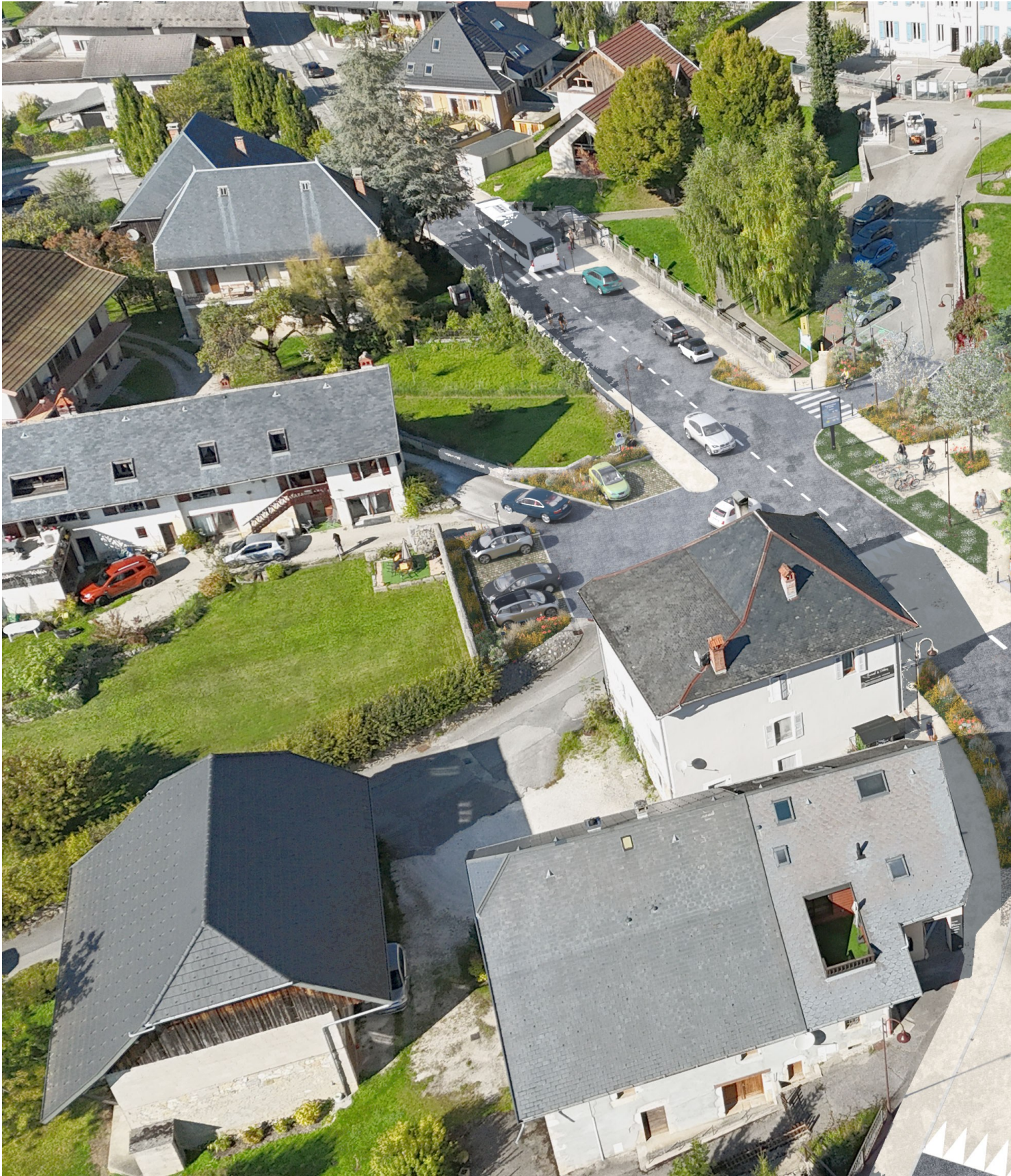
VUE D'ENSEMBLE DU PROJET DE SECURISATION ET DE PIETONISATION DU CENTRE L'ESPACE PIETONNIER.
